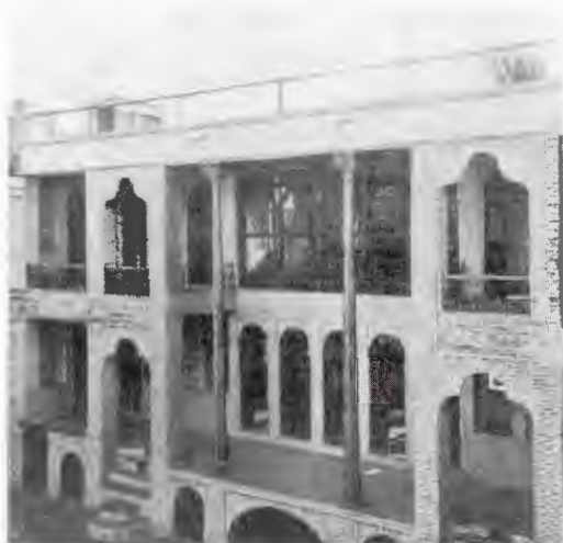
شكل ٣٦ نفس البيت والصورة لواجهة مبنى الحرم
